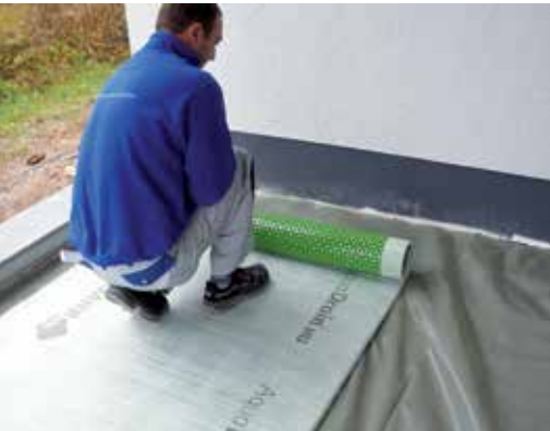
AquaDrain® HU Flächendrainage ausrollen
