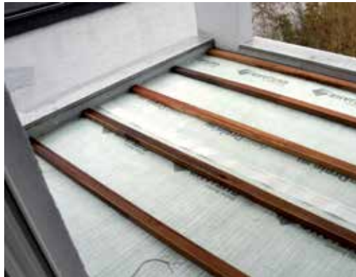
Unterlattung zuschneiden und auf AquaDrain® HU verlegen
