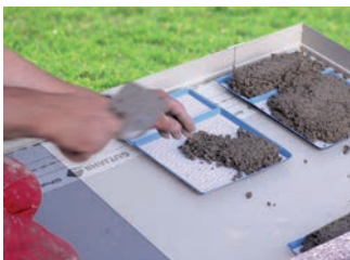
Das TerraMaxx ® DS Drain-Stelzlager wird mit Drainmörtel aufgefüllt.
